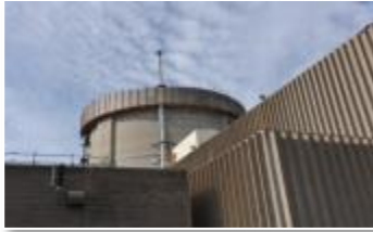
Système de ventilation filtrée d'urgence
