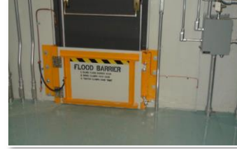
Barrières contre les inondations
