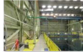
Améliorations aux piscines de combustible usé
