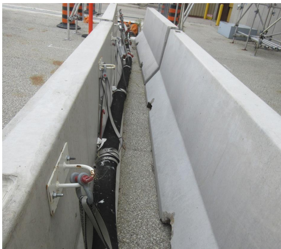
Figure 2 : Photo montrant les conduites du CES temporaire et leurs dispositifs de retenue situés à l'extérieur de Bruce-B
