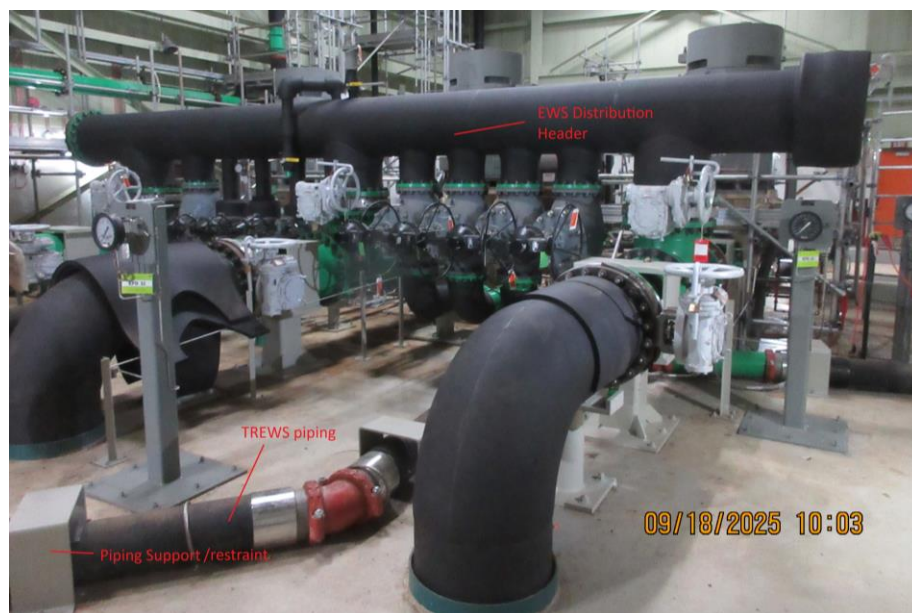
Figure 1 : Photo montrant le raccordement des conduites du CES temporaire au collecteur de distribution du CES
