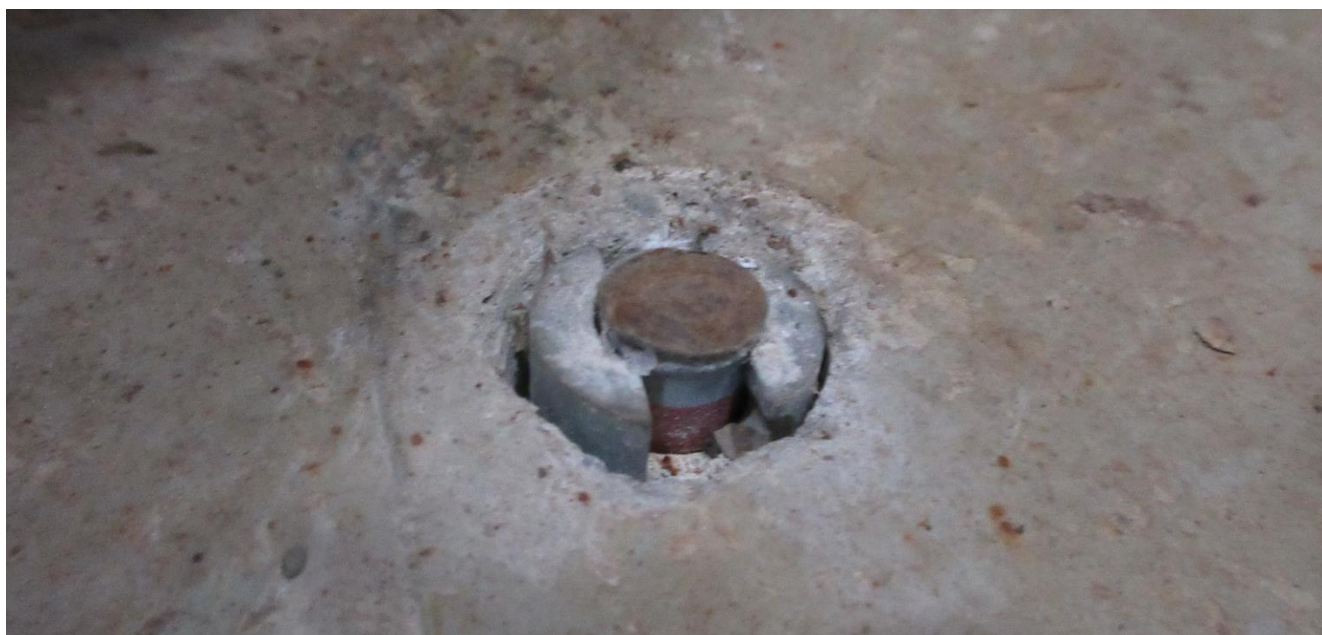
Figure 5 : Photo montrant un dispositif d'ancrage coupé et inutilisé en raison d'un problème lié à l'emplacement d'un autre ancrage; le dispositif de retenue a donc été déplacé
