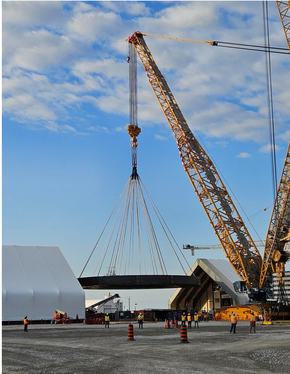
Figure 2 : La dalle de fondation est hissée hors du bâtiment de préassemblage. (Source : personnel de la CCSN, avril 2026)
