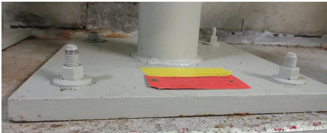
Figure 4 : Photo montrant que les ancrages, d'après le filetage dépassant de la plaque d'assise, sont de longueurs variables
