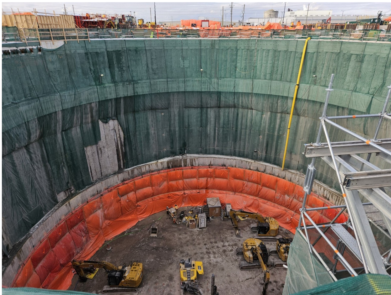
Figure 1 : Excavation du puits du bâtiment du réacteur, vue en plongée (source : personnel de la CCSN, février 2026)
