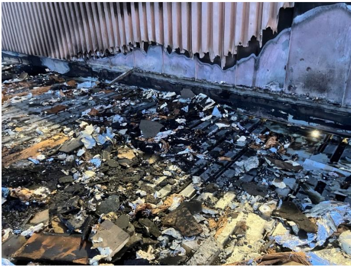
Figure 3 ci-dessus : section de la toiture où le feu a pénétré le bâtiment
