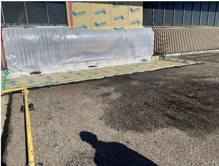
Figure 7 ci-dessus : surface du toit et murs du bâtiment recouverts de contreplaqué et d'une bâche pour remplacer temporairement les fenêtres aux fins de protection
