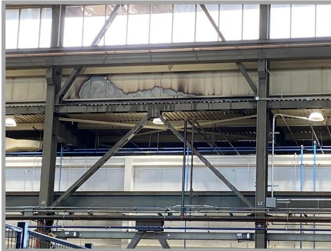
Figure 4 ci-dessus : dommages à l'intérieur du bâtiment, là où le feu a pénétré le bâtiment
