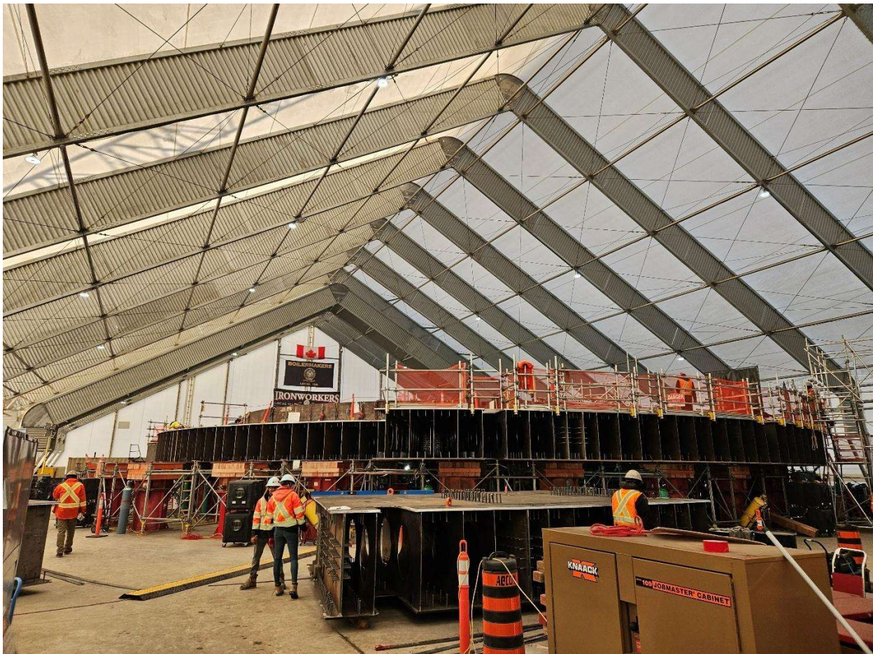
Figure 1 Vue latérale de l'assemblage du radier du bâtiment du réacteur dans la structure de préassemblage (Source: le personnel de la CCSN, janvier 2026).
