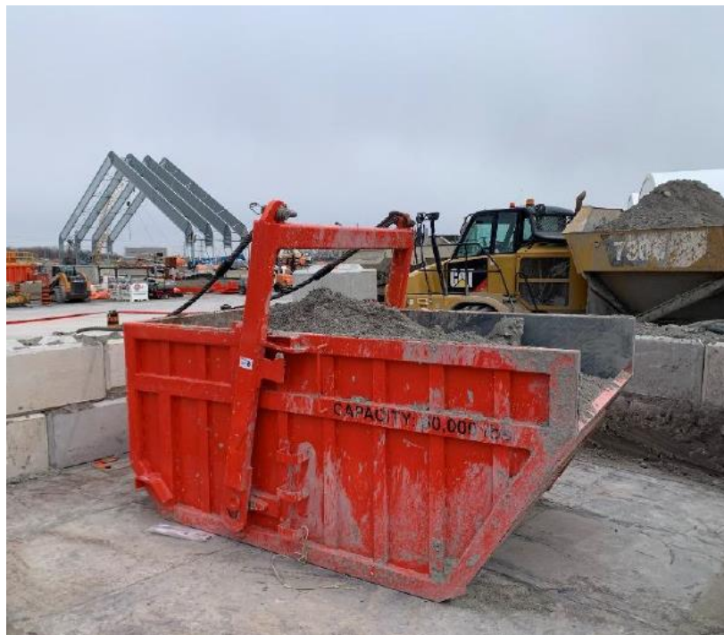
Figure 2 : L'intérieur de l'enclos; la grande benne rouge s'est déplacée et a coincé le travailleur contre le mur en blocs de béton.
