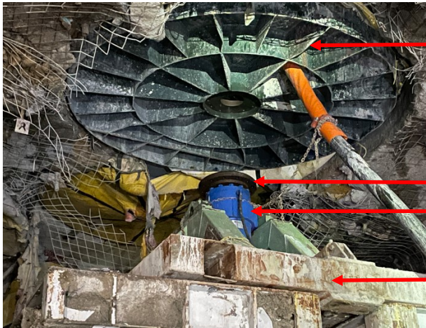
Figure 2 : Configuration simulée d'un bouchon de remblai placé sur un portique de remblayage (source : MRSMTS)
