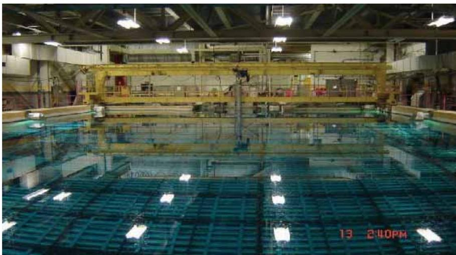
**Figure 4.1** — Stockage en piscine à la centrale nucléaire Pickering
