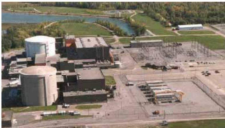
**Figure 4.7** — Installation de stockage à sec du combustible usé de Gentilly-2 (au bas de la photo à droite)
