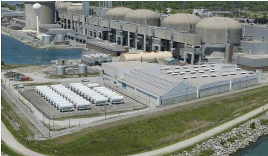
**Figure 5.1** — Installation de gestion des déchets de Pickering avec la ZSCT à gauche et la zone de stockage à sec du combustible usé à droite
