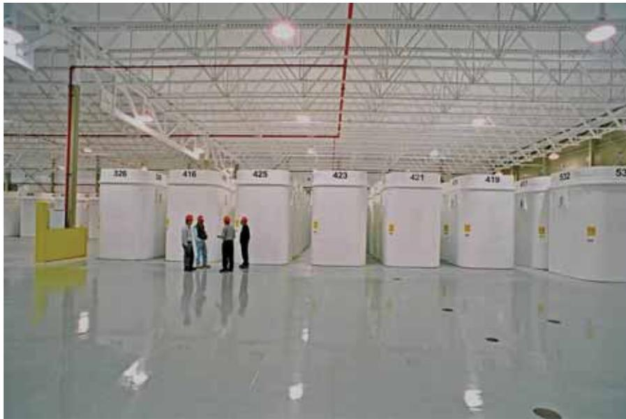
Figure 4.4 — Conteneurs de stockage à sec à l'installation de gestion des déchets de l'Ouest
