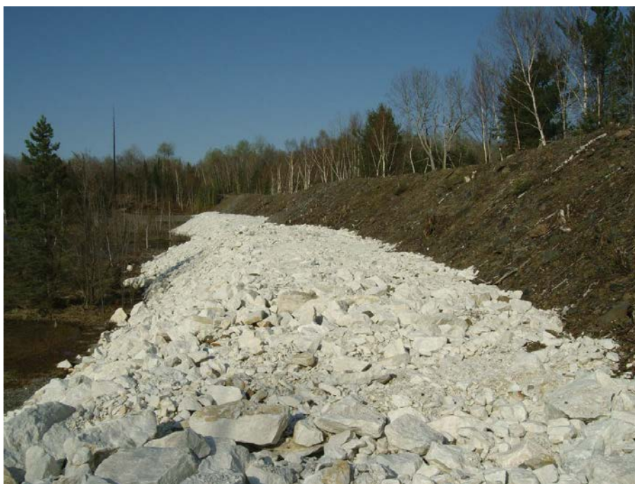
Figure 8.8 : Barrage principal de résidus de la mine Dyno
