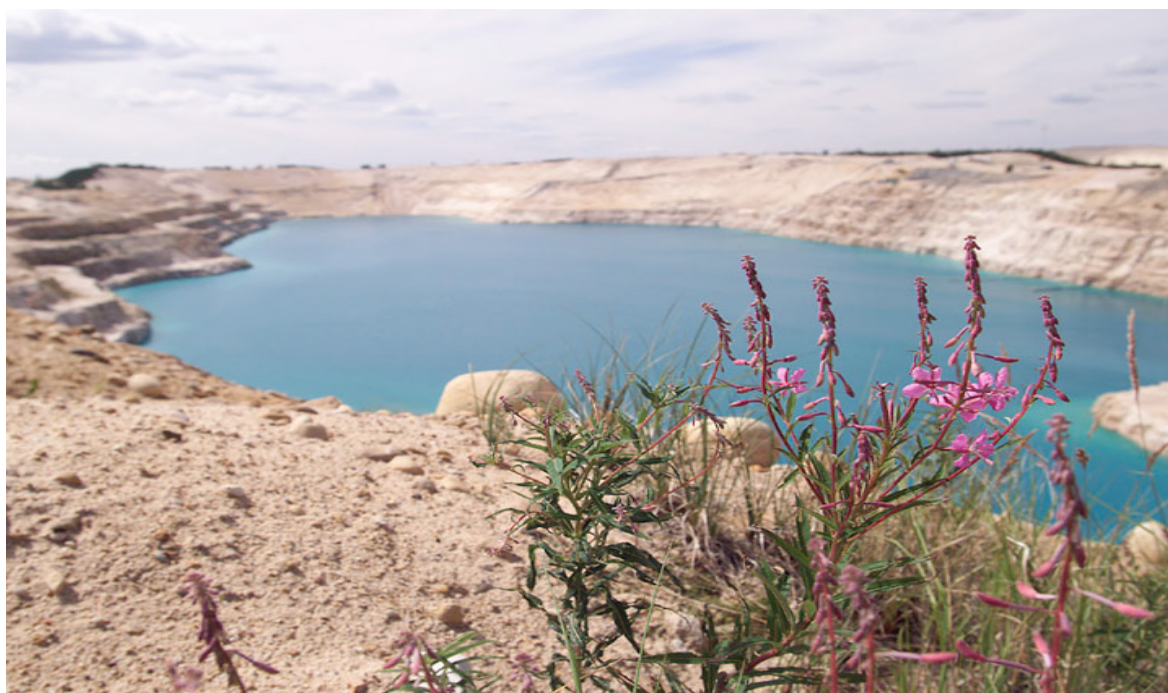
Figure 6.1 : Installation de gestion des résidus Deilmann à Key Lake
