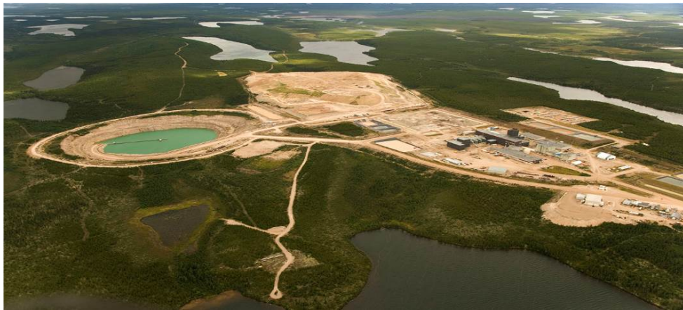
Figure 6.3a) : Site de McClean Lake; l'installation de gestion des résidus John Everett Bates est située à gauche de l'usine de concentration
