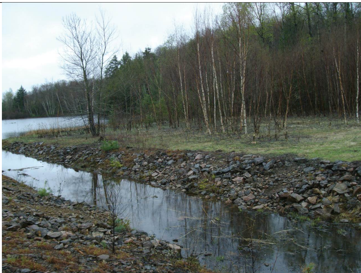
Figure 8.9 : Déversoir du bassin de résidus sud de l'installation de stockage de résidus Bicraft
