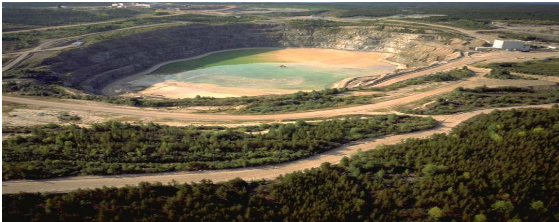
Figure 6.2 b) : Installation de gestion des résidus en fosse de Rabbit Lake
