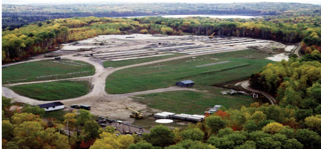
Figure 5.7 : Zone de gestion des déchets B au site des LCR
