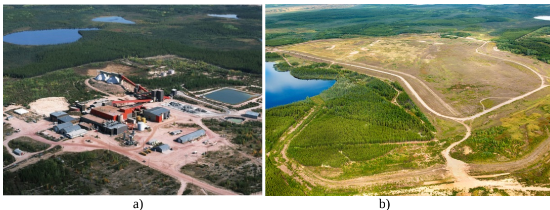
Figures 7.2a) et b) : a) Vue du secteur de l'usine de Cluff Lake pendant l'exploitation; b) vue de la zone après le déclassement, mais avant la reprise de la végétation
