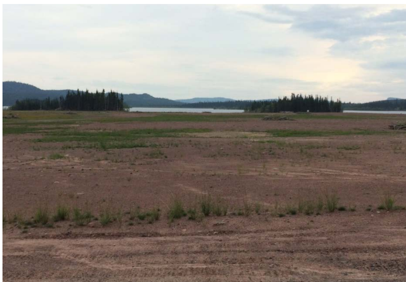
Figure 8.5 : Site des résidus de Lorado remis en état
