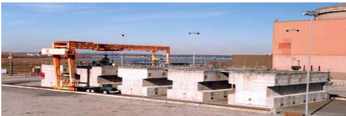
Figure 4.3 : Module MACSTOR à Gentilly-2
