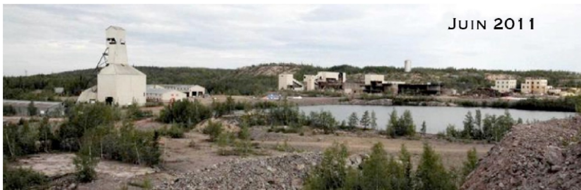
Figure 8.3 : Avant l'exécution des travaux ordonnés par la CCSN
