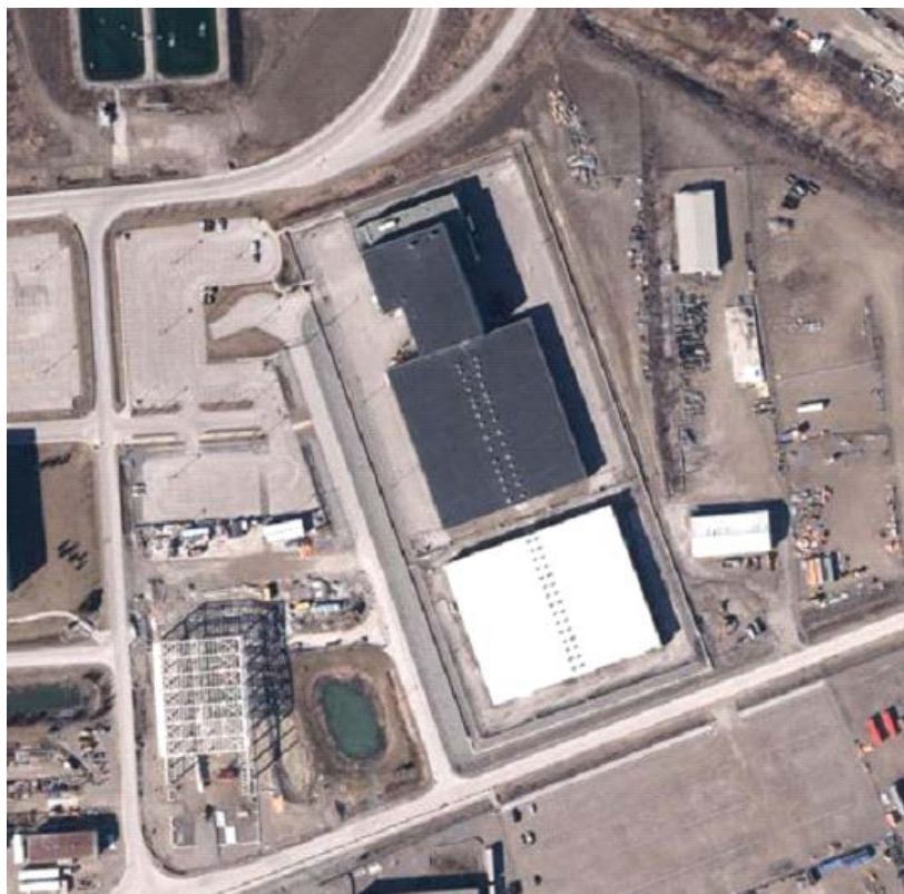
Figure 4.6 : Vue aérienne de l'installation de gestion des déchets de Darlington
