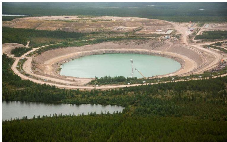
Figure 6.3 b) : Installation de gestion des résidus de la mine John Everett Bates à McClean Lake
