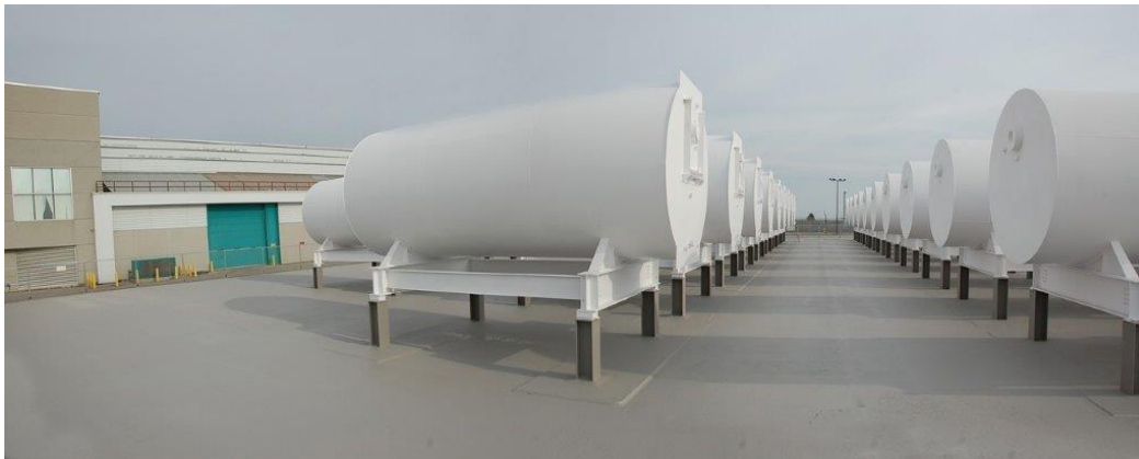
Figure H.1 : Modules de stockage à sec contenant des déchets de retubage de Pickering-A (tranches 1 à 4) à l'IGD de Pickering d'OPG
