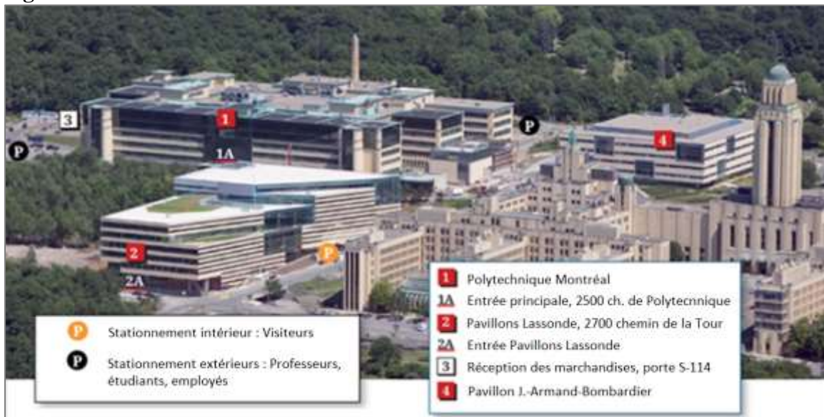
Figure O-1: Vue aérienne de l'EPM
