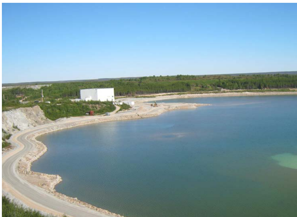
Figure 5.2 : Installation de gestion des résidus en fosse à Rabbit Lake, 2016
