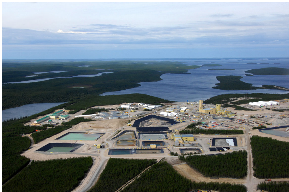
Figure 3.1 : Vue aérienne de l'établissement de Cigar Lake
