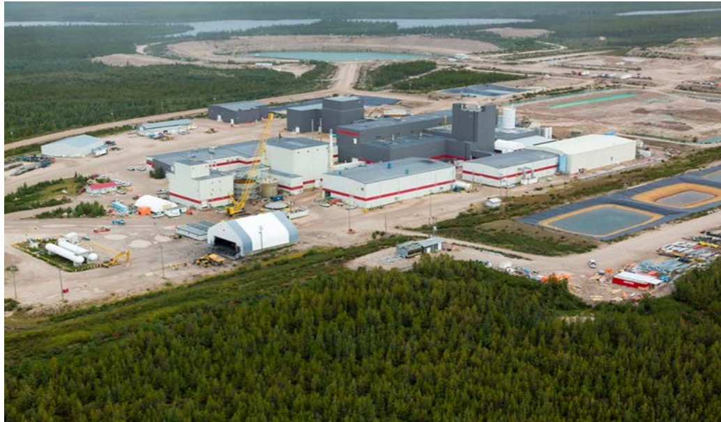
Figure 7.1 : Vue aérienne de l'établissement de McClean Lake
