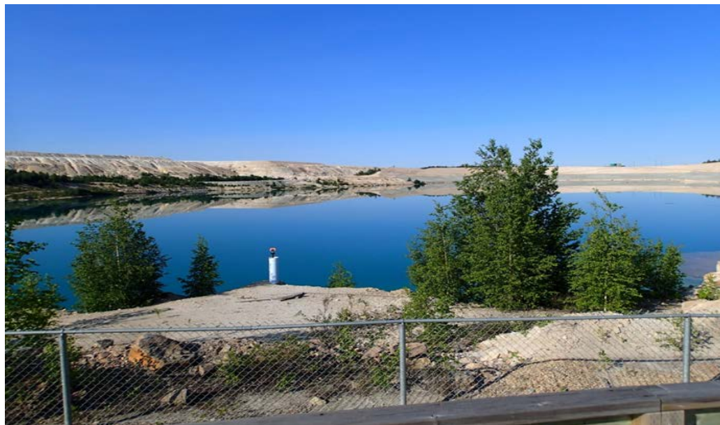
Figure 6.2 : Installation de gestion des résidus Deilmann à l'établissement de Key Lake
