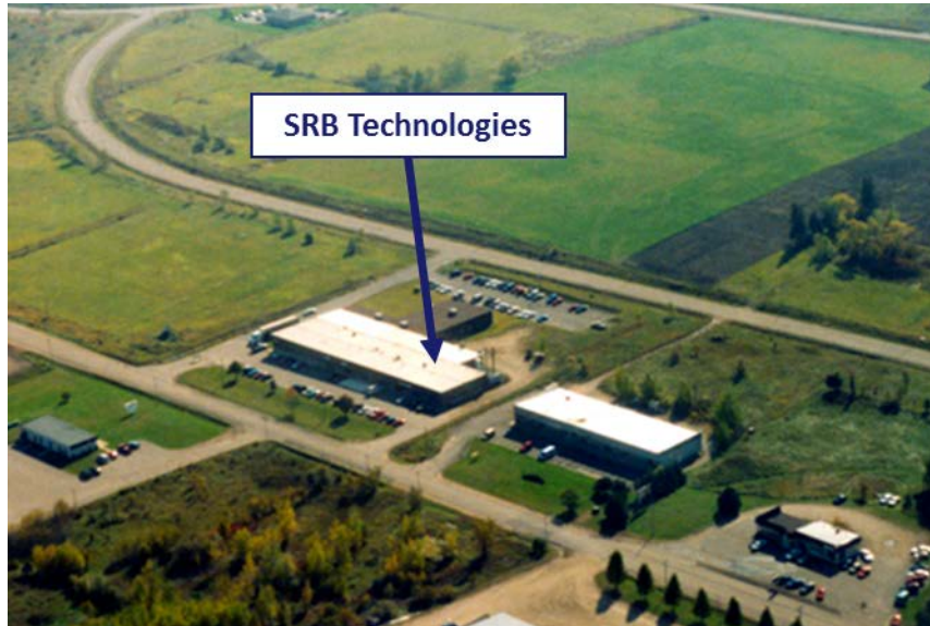
Figure 8-1 : Vue aérienne de l'installation de SRBT
