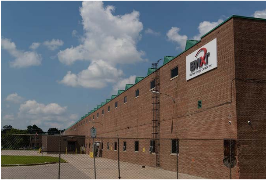
Figure 6-2 : Vue de côté de l'installation de BWXT à Peterborough
