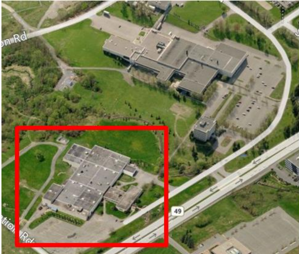
Figure 10-1 : Vue aérienne de l'installation de BTL
