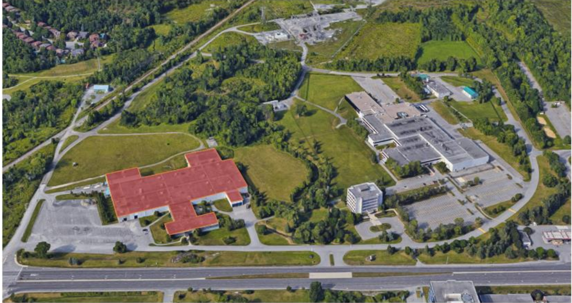
Figure 10-1 : Vue aérienne de l'installation de BTL
