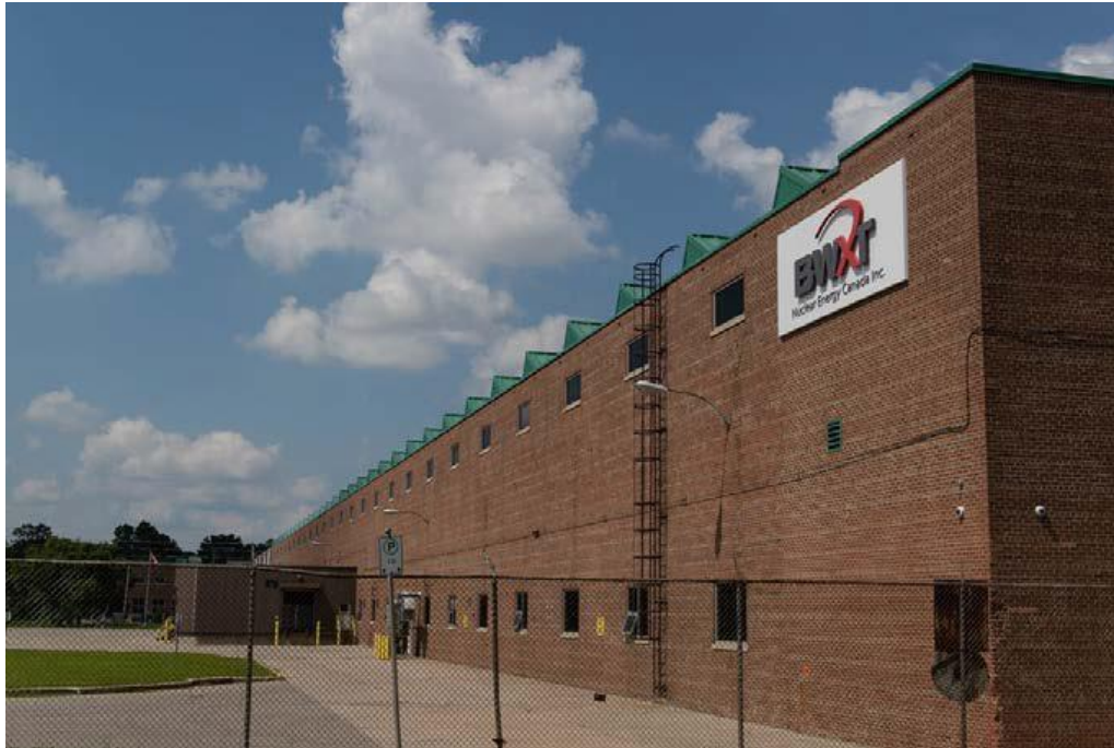
Figure 6-2 : Installation de BWXT à Peterborough
