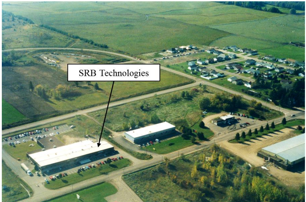
Figure 8-1 : Vue aérienne de l'installation de SRBT
