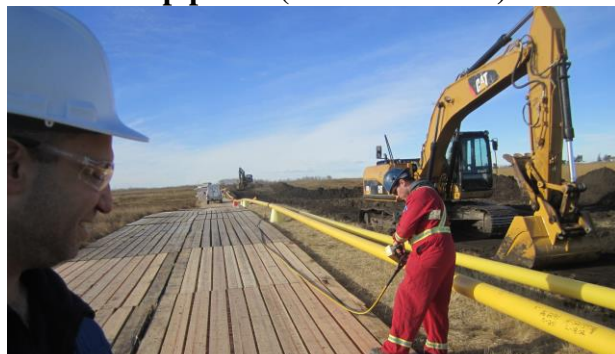
Figure 2 : Un inspecteur de la CCSN observe un opérateur d'appareil d'exposition se préparant à effectuer une procédure de gammagraphie industrielle sur un pipeline (Source : CCSN)
