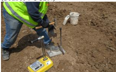
Figure 62 : Jauge portative en utilisation sur un chantier (Source : CCSN)
