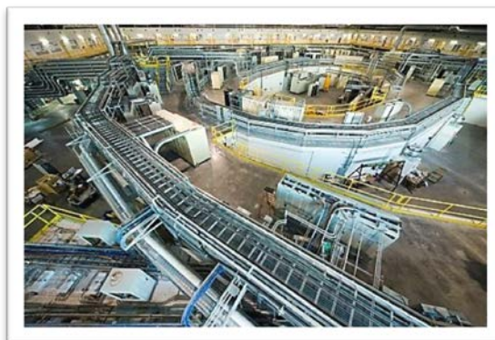
Figure 10 : Installation de recherche du CCRS
