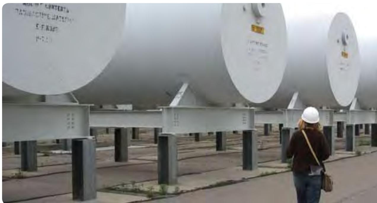
*Une agente de projet de la CCSN inspecte l'installation de stockage des composants de retubage à l'établissement de gestion des déchets de Pickering. On y stocke des déchets radioactifs autres que le combustible irradié qui sont générés par les activités de remise en état à la centrale nucléaire Pickering.*
