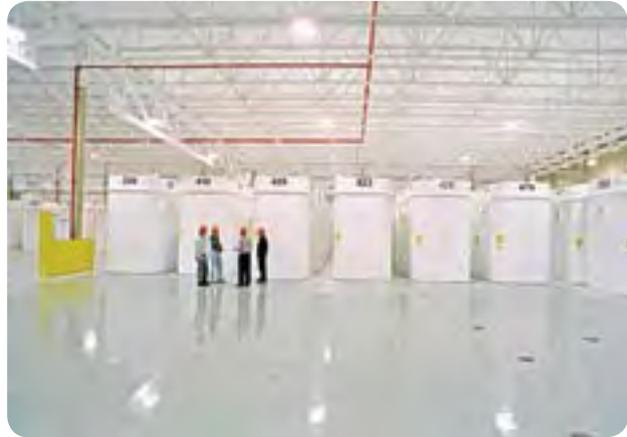
*Le combustible irradié est placé dans des silos de stockage sécurisés.*
