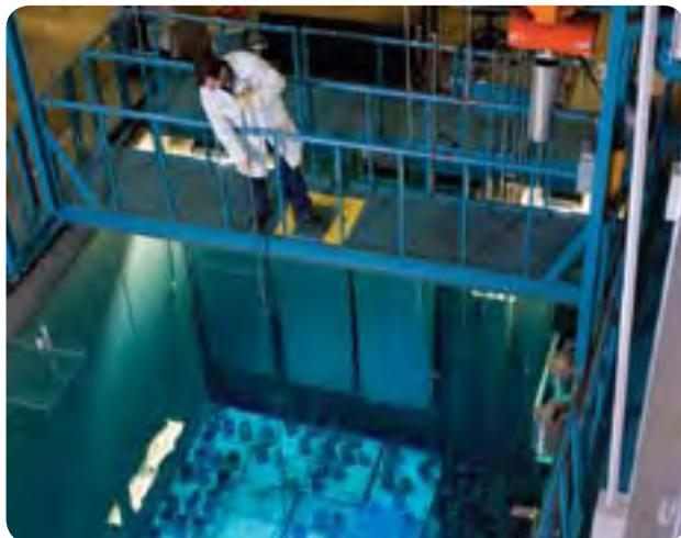
*Un technicien d'une installation de titulaire de permis de la CCSN inspecte le stockage de matières radioactives dans une piscine de désactivation.*
