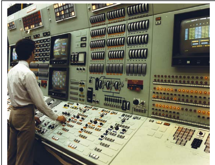
Un travailleur à la centrale nucléaire de Bruce utilise le simulateur de salle de commande.
