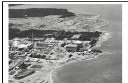
Image de la centrale nucléaire de Douglas Point, maintenant déclassée
