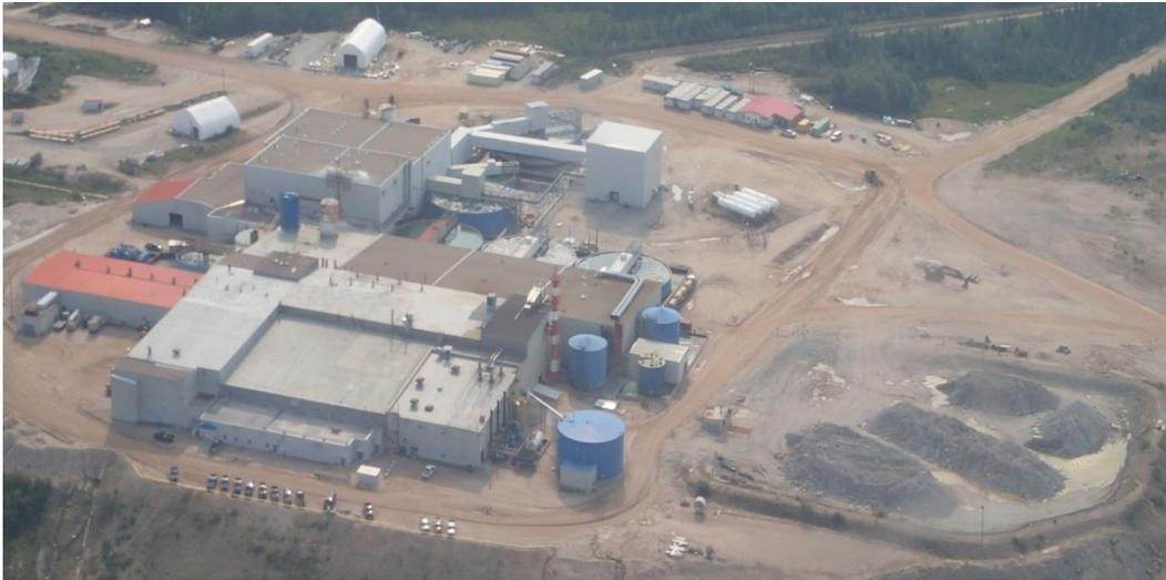
**Figure 5-2 : Usine de concentration de Rabbit Lake avec l'installation de gestion des résidus en fosse active à l'arrière-plan**
