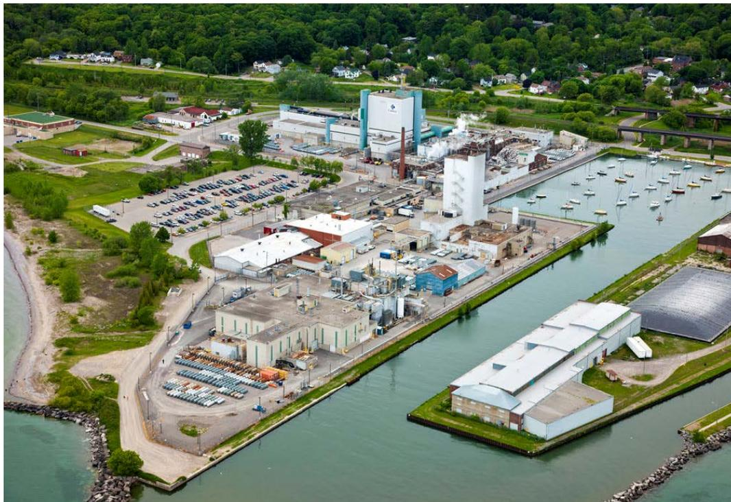
L'ICPH convertit principalement la poudre de trioxyde d'uranium ( $\text{UO}_3$ ) produite par la RBR de Cameco en dioxyde d'uranium ( $\text{UO}_2$ ) et en hexafluorure d'uranium ( $\text{UF}_6$ ). L' $\text{UO}_2$  sert à fabriquer le combustible des réacteurs CANDU (uranium naturel), tandis que l' $\text{UF}_6$  est exporté pour un traitement supplémentaire avant d'être converti en combustible pour les réacteurs à eau légère.
