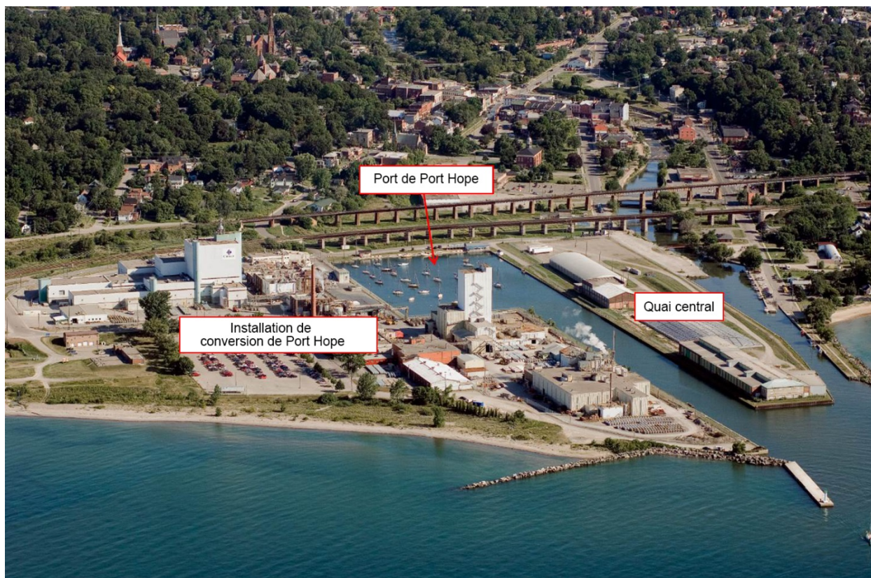
Figure 12 : Vue aérienne du port et de l'Installation de conversion de Port Hope
