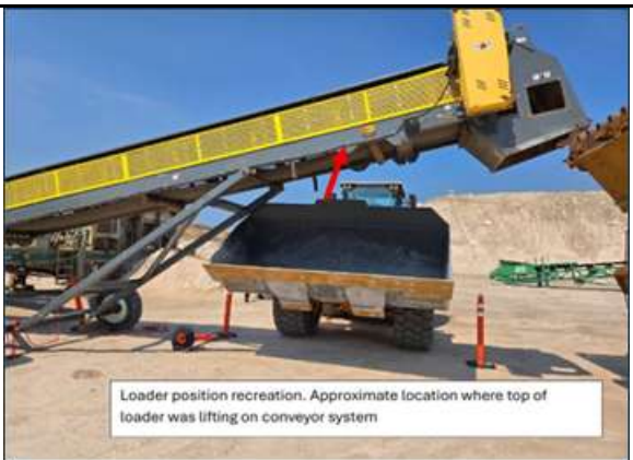
Fig. 2. Vue, après l'incident, de l'extrémité surélevée de la tête de l'appareil de gerbage. Le godet du chargeur est adjacent au cadre, illustrant le contact entre le chargeur et l'appareil de gerbage.
