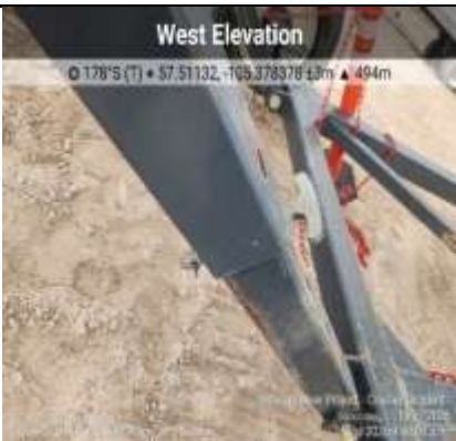
Fig. 5. Gros plan du support coulissant et de la disposition de la goupille en T.
