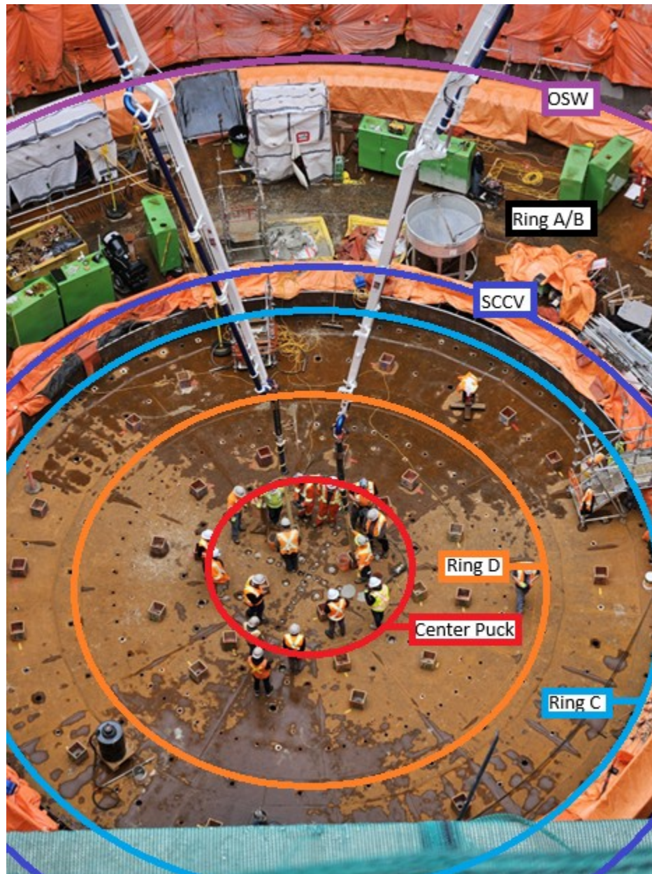
Figure 1 : Coulage du béton de la rondelle centrale et des anneaux C et D
