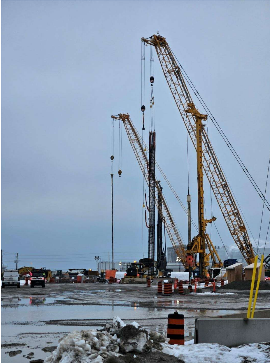
Figure 6 Installation de l'une des cages d'armature du bâtiment de la turbine (à l'avant-plan) (Source : personnel de la CCSN, janvier 2026)
