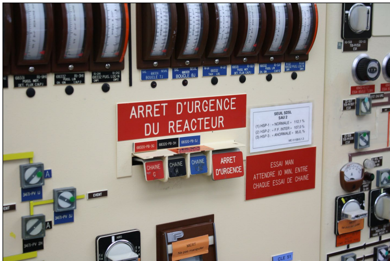
Photo 3 : Commandes d'arrêt d'urgence du réacteur de Gentilly-2
