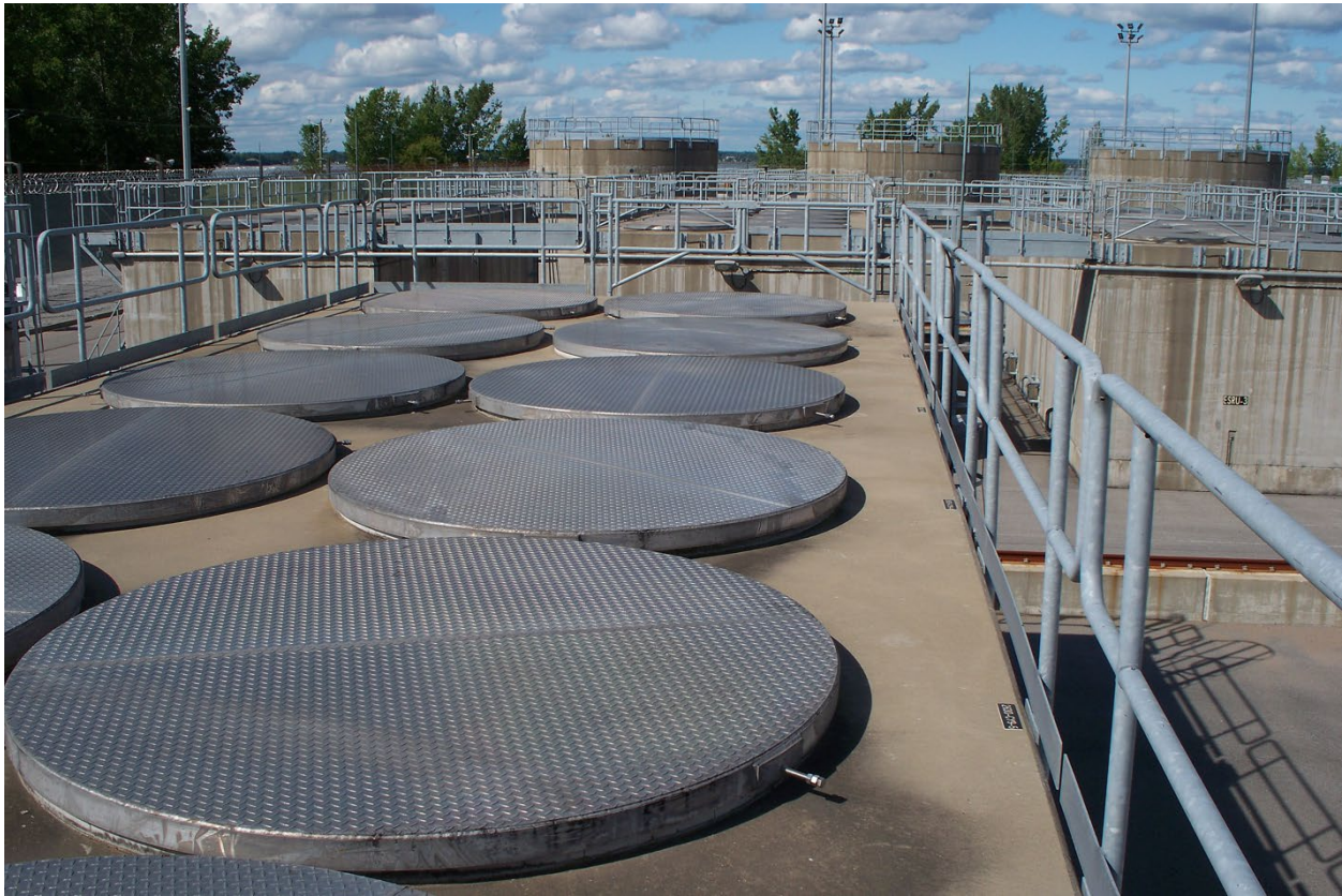
Photo 2 : Enceintes contenant des déchets radioactifs solides à Gentilly-2
