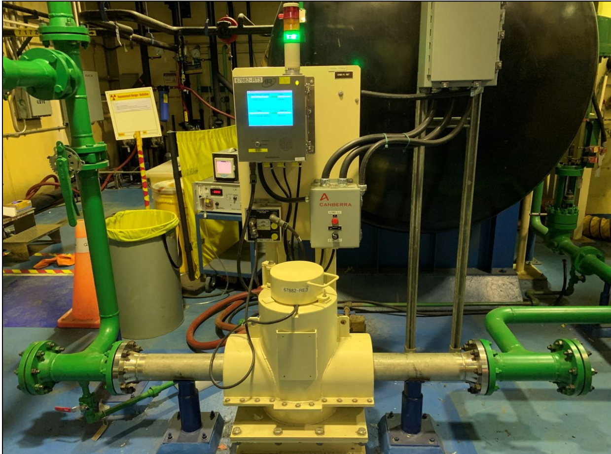
Photo 4 : Moniteur d'effluents radiologiques liquides de Gentilly-2
