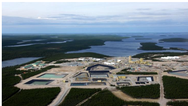
Figure 3.1.1: Établissement de Cigar Lake – Vue aérienne vers le nord
