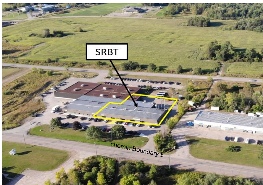
Figure 3-1 : Vue aérienne de l'installation de SRBT délimitée en jaune (source : SRBT)
