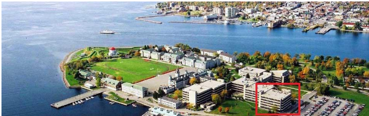
Figure 4-2 : Vue aérienne de l'installation du Collège militaire royal délimitée en rouge (source : page Web du CMR)
