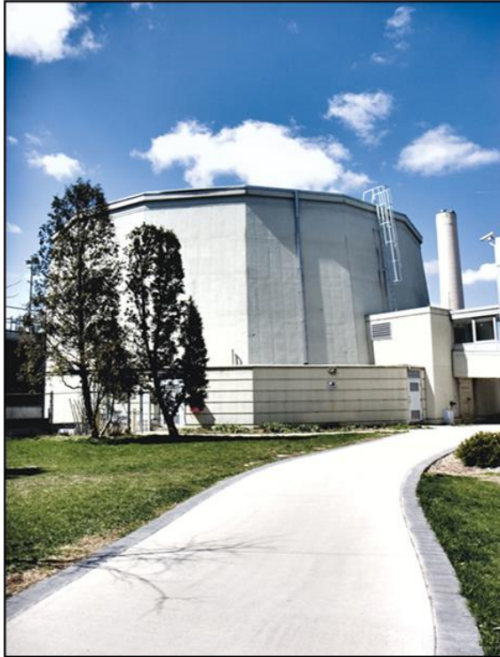
Figure 4-1 : Vue extérieure du RRNM et de son bâtiment de confinement (source : site Web de l'Université McMaster)
