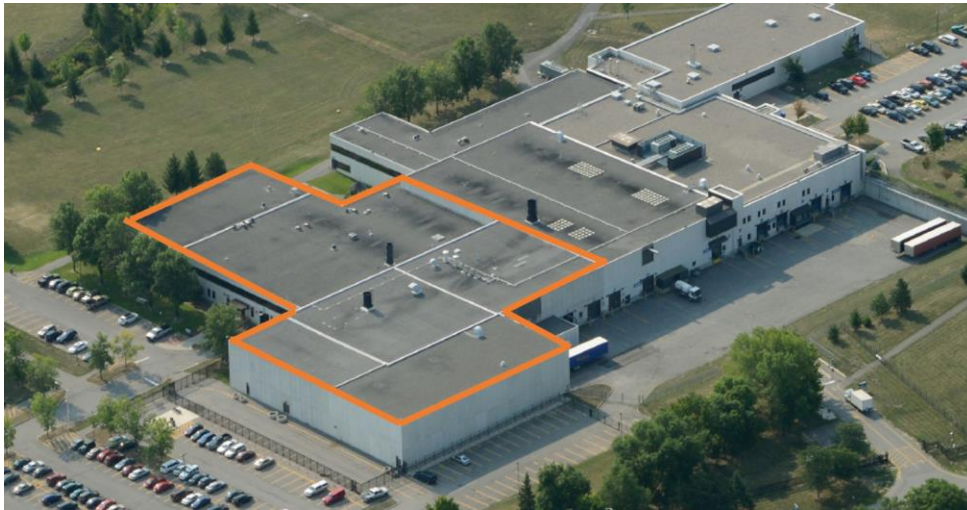
Figure 3-2 : Vue aérienne de l'installation de Nordion délimitée en orange (source : Nordion/Canadian Aerial Photo Corporation)
