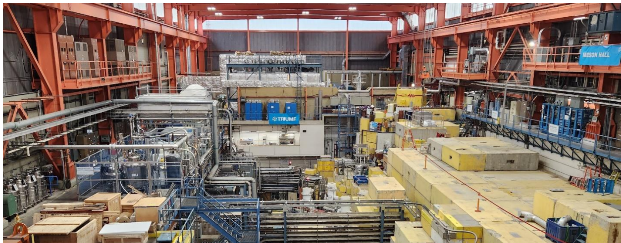
Figure 5-1 : Intérieur de l'installation du Centre canadien de rayonnement synchrotron | Flickr 1 (source : CCRS)
