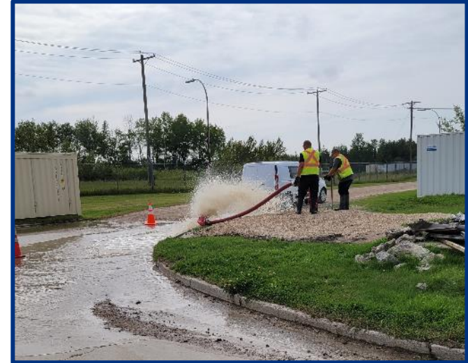
Essai de débit d'une borne d'incendie. Source : personnel de la CCSN
