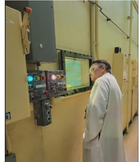
Le personnel de la CCSN évalue la charge d'incendie dans l'installation de cellules de haute activité des LW.
