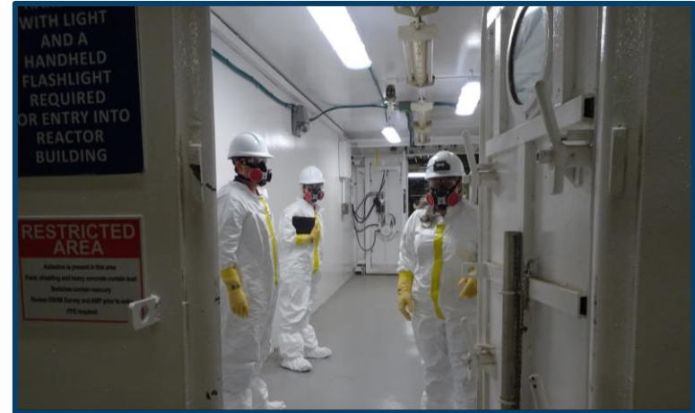
Personnel de la CCSN effectuant une inspection à Douglas Point
