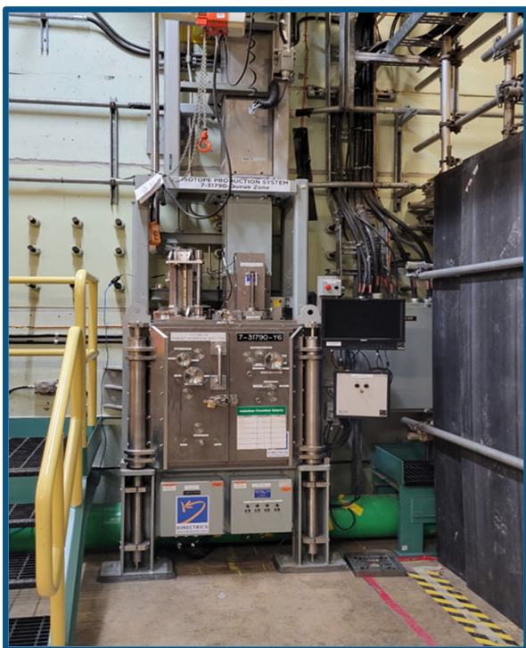
Patin de l'interface de la cible du système de production d'isotopes (SPI)
