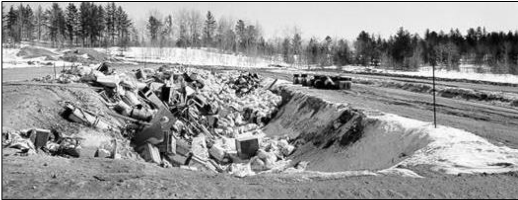
Figure 4: Tranchée sans revêtement dans une ancienne zone de gestion des déchets (années 1960)
