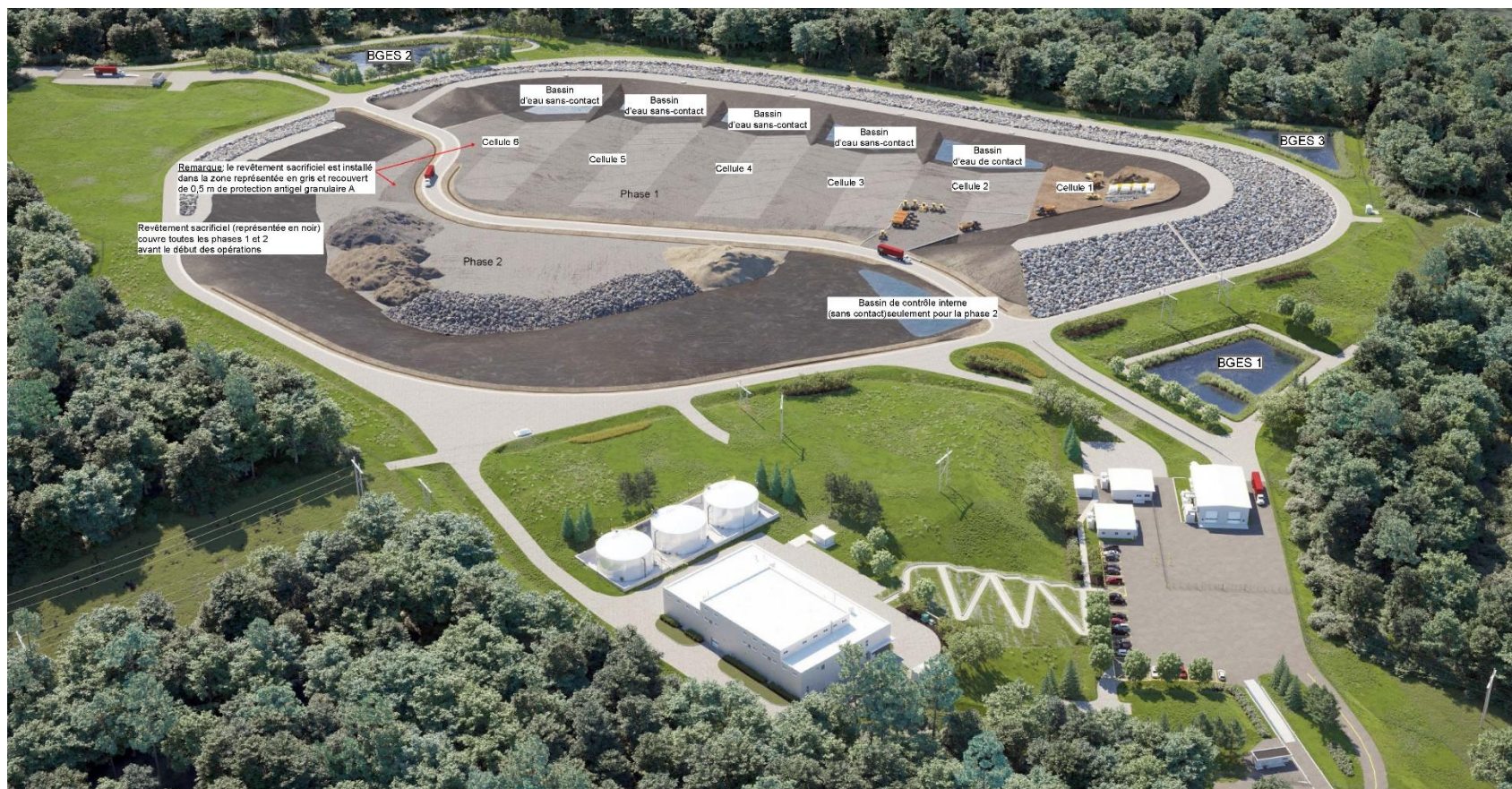
Figure 22: Rendu d'artiste de la disposition des cellules de stockage du monticule de confinement artificiel
