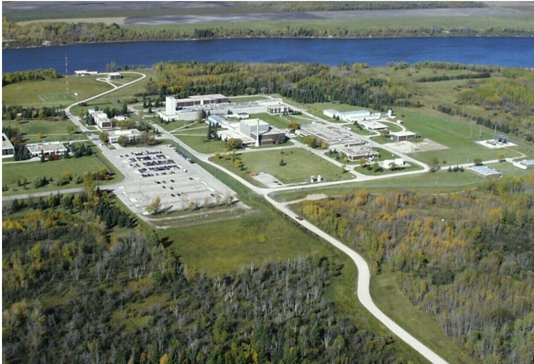
Figure 3 : Complexe principal des LW (Source : LNC)
