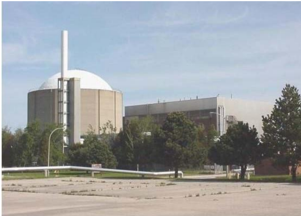
Figure 6 : Installation de déchets de DP (Source : LNC)
