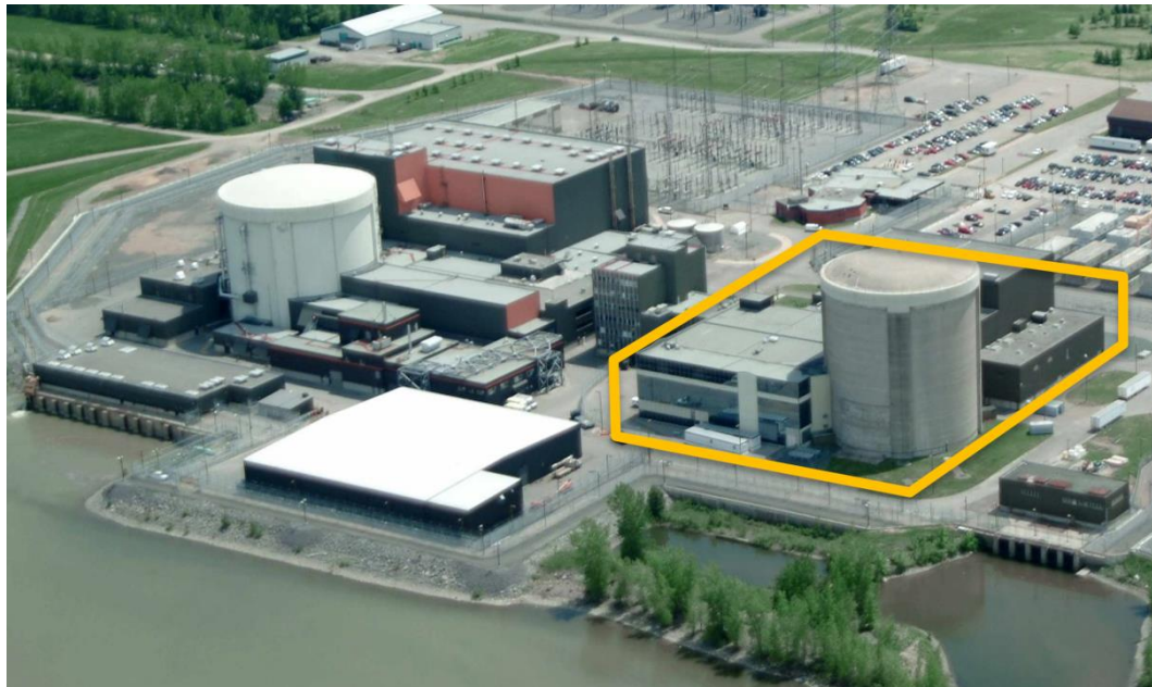
Figure 7 : Installation de gestion des déchets de G-1, délimitée par la ligne jaune (Source : LNC)
