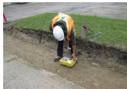
Figure 5 : Travailleur utilisant une jauge portative pour mesurer les caractéristiques du sol (source : CCSN)
