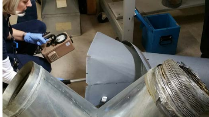
Figure 8 : Vérification de la contamination au cours d'une inspection (source : CCSN)
