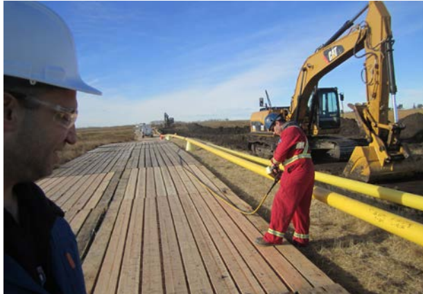
Figure 2 : Inspection d'un opérateur d'appareil d'exposition (Source : Personnel de la CCSN)
