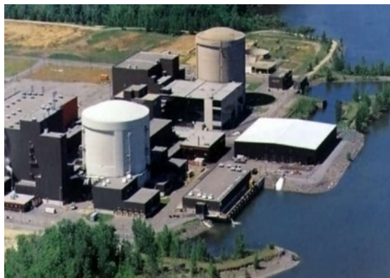
Figure 10 : Installations de Gentilly-2
