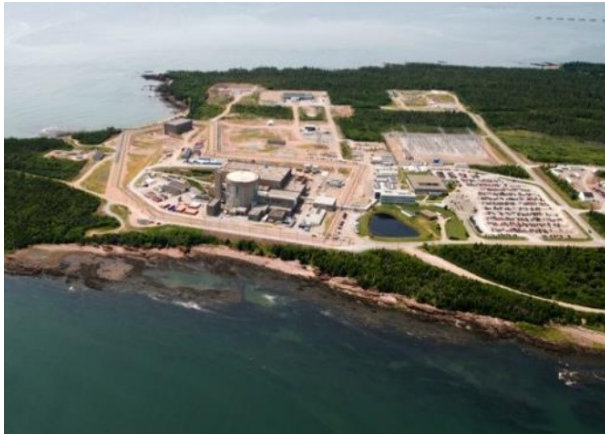
Figure 9 : Centrale nucléaire de Point Lepreau
