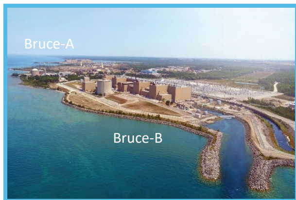
Figure 7 : Centrale nucléaire de Bruce-A et de Bruce-B
