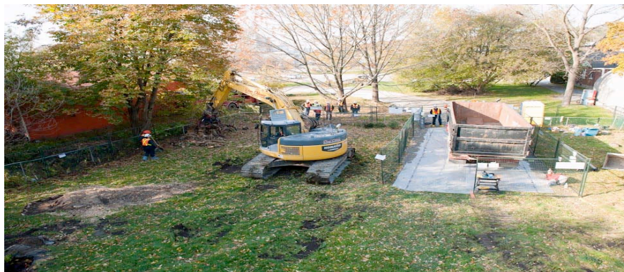
Figure K.5 — Essai d'assainissement à Port Hope
