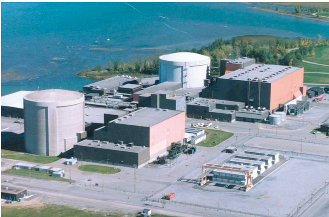
Figure 4.7 — Installation de stockage à sec du combustible usé de Gentilly-2 (au bas de la photo, à droite)
