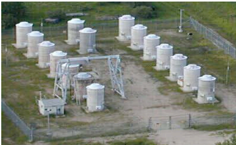
Figure 4.10 — Installation de stockage en silos de béton (ISSB) des Laboratoires de Whiteshell
