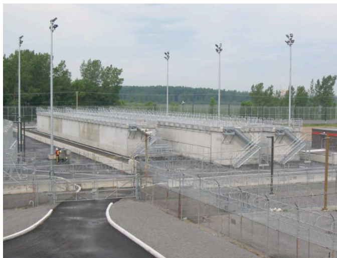
Figure 5.3 — Zone de stockage à sec du combustible usé et zone de gestion des déchets faiblement radioactifs de Gentilly-2
