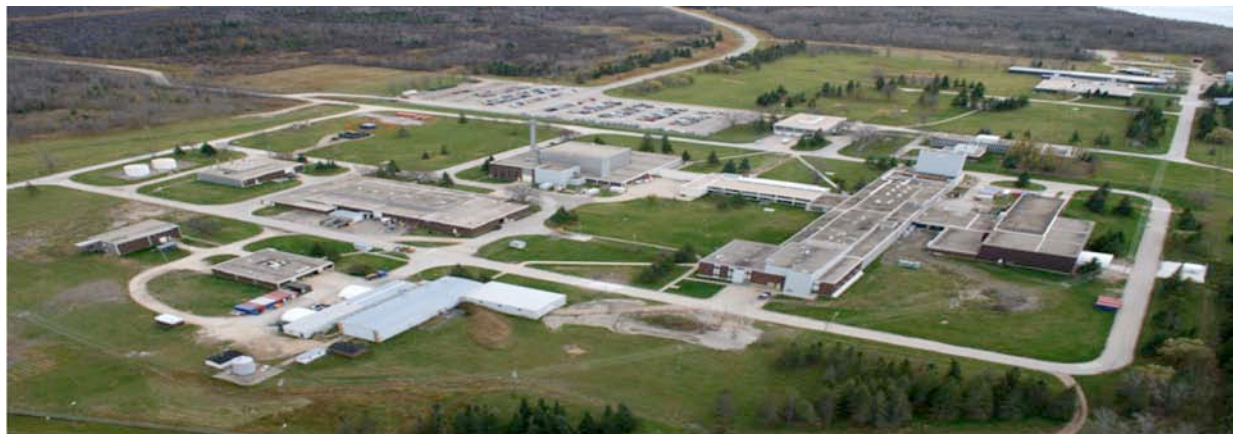
Figure 7.1 — Vue aérienne du site principal des Laboratoires de Whiteshell
