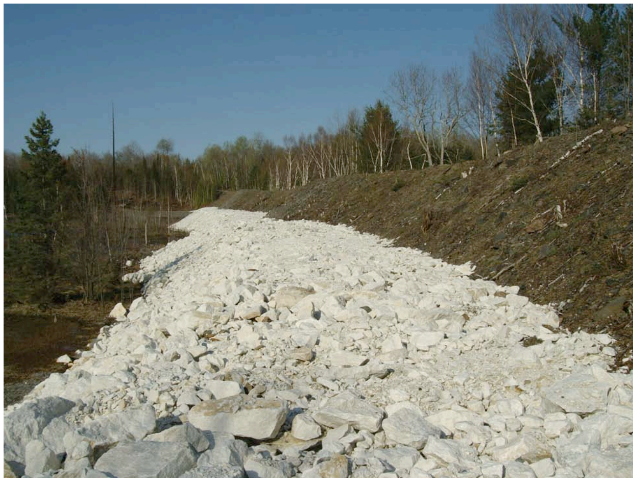
Figure 8.7 — Digue principale de résidus de la mine Dyno
