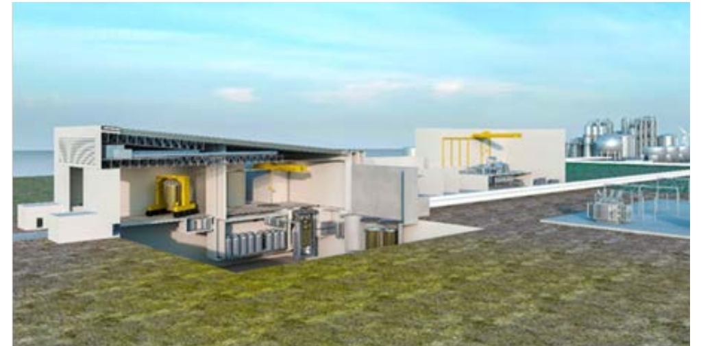
Exemple d'une technologie PRM : Vue en coupe de l'installation Réacteur intégral à sels fondus de Terrestrial Energy (IMSR-4000) – (image fournie par Terrestrial Energy)
