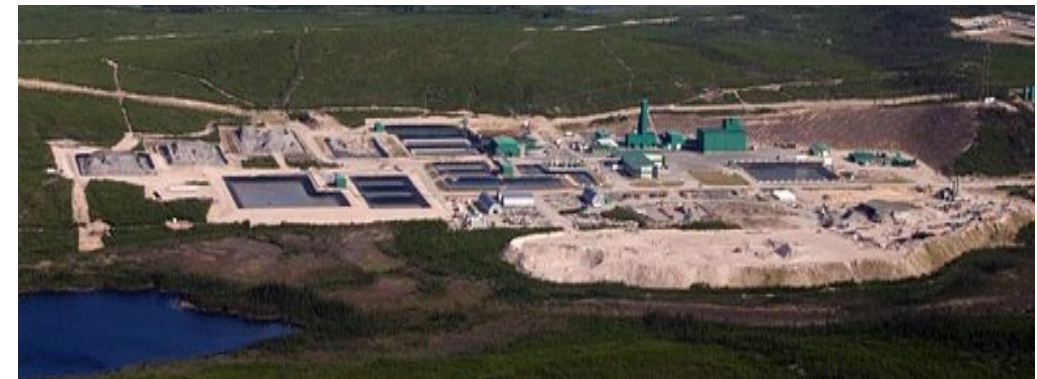
Photo du haut : Usine de concentration de Key Lake
