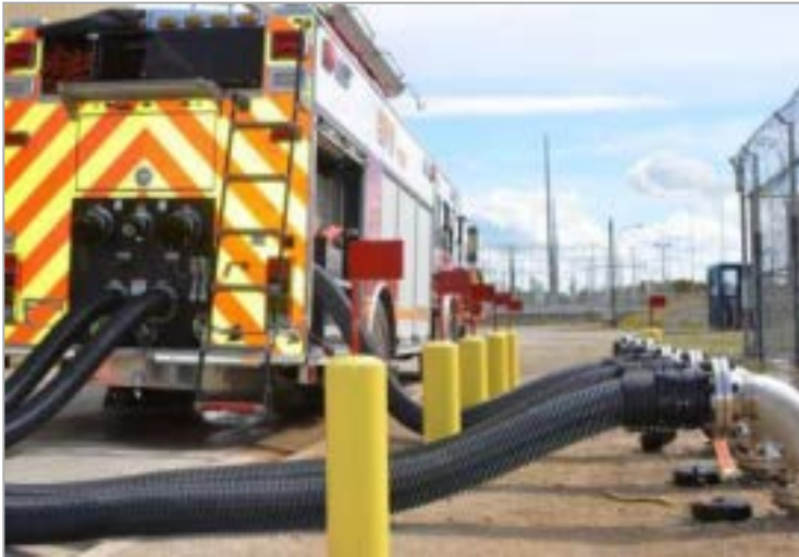
Les camions-pompes d'incendie de la Bruce Power fournissent de l'eau de refroidissement. Du nouveau matériel de pompage d'eau en cas d'urgence a été acheté et se trouve sur place.
