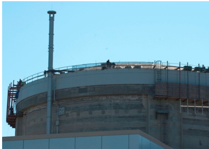
Cheminée d'évent filtré en cas d'urgence à Point Lepreau
