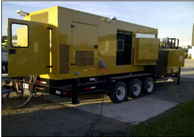
Groupe électrogène (2) de 400 kW de Bruce-A
