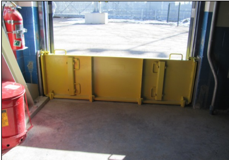
Protection contre les inondations
