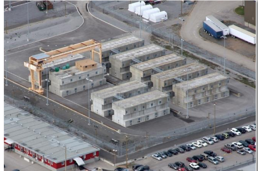
Stockage à sec en surface sur le site de Gentilly-2 (photo gracieuseté d'Hydro-Québec)
