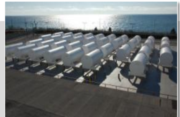
Déchets radioactifs provenant des travaux de réfection et stockés dans des conteneurs en surface
