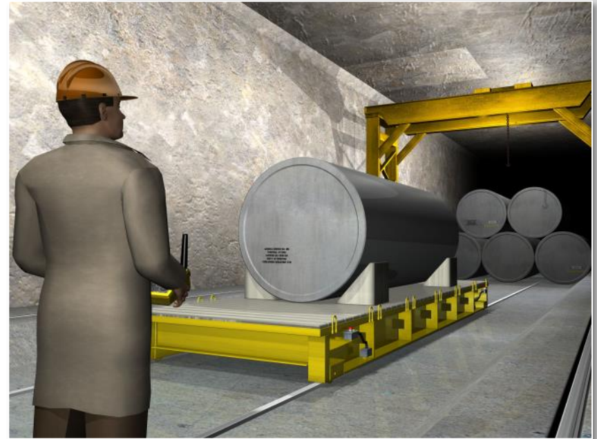
Conception d'emplacement destiné aux déchets radioactifs de moyenne activité
