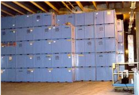
Déchets radioactifs de faible activité stockés dans des bâtiments de type entrepôt
