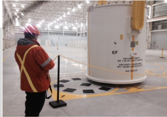
Contenant de suremballage blindé destiné au stockage à la centrale de Darlington
