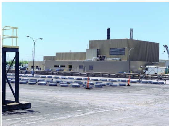
Bâtiment de réduction du volume de déchets
