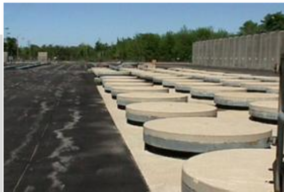
Déchets plus radioactifs et de période plus longue stockés dans des conteneurs dans le sol
