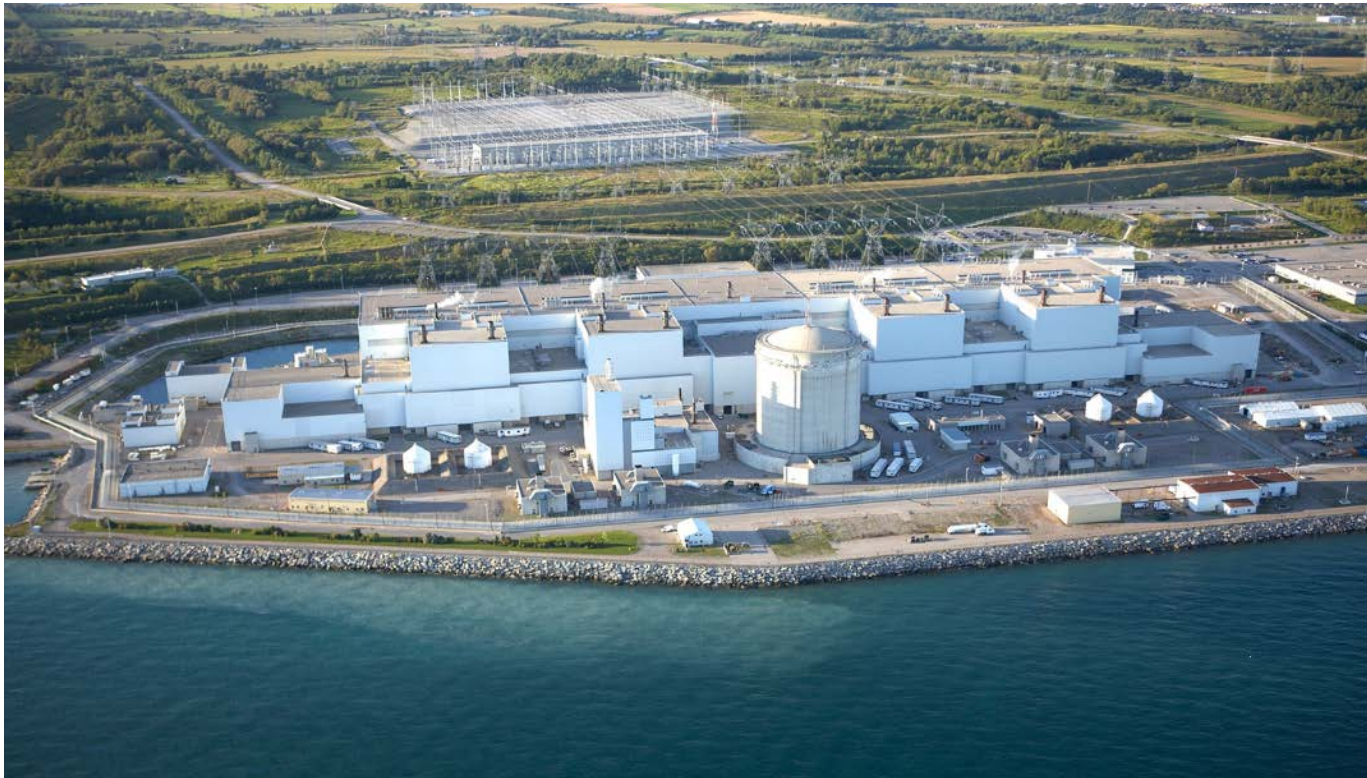
Vue aérienne de la centrale nucléaire de Darlington
