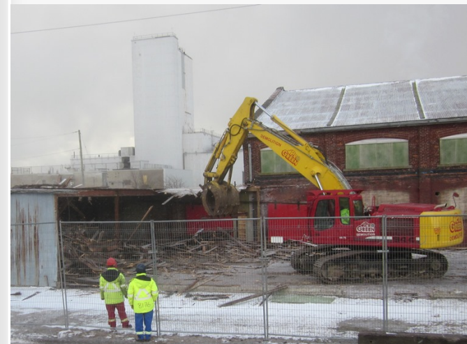
Démolition du bâtiment 42 sur le quai central. Photographie : Cameco
