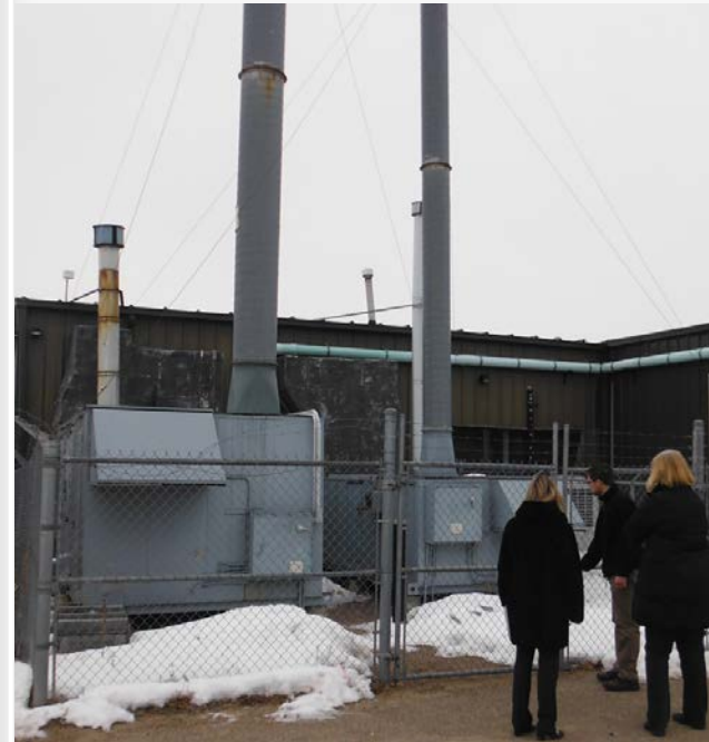
Personnel de la CCSN inspectant les cheminées de l'installation de SRB Technologies Photographie : CCSN
