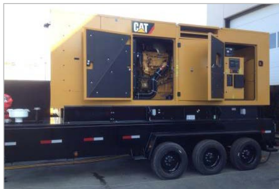
Système d'alimentation de secours et connexions - 4 au total à Point Lepreau
