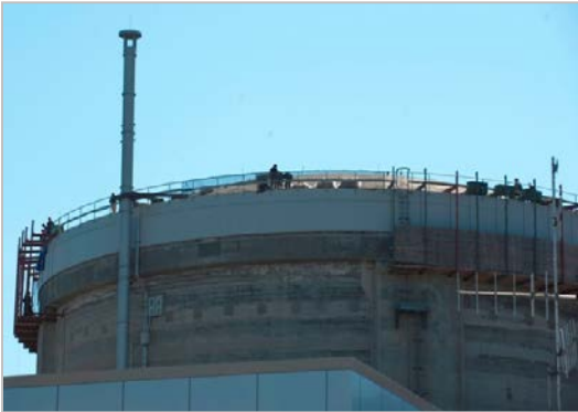
Ventilation d'urgence du confinement avec filtrage de Point Lepreau
