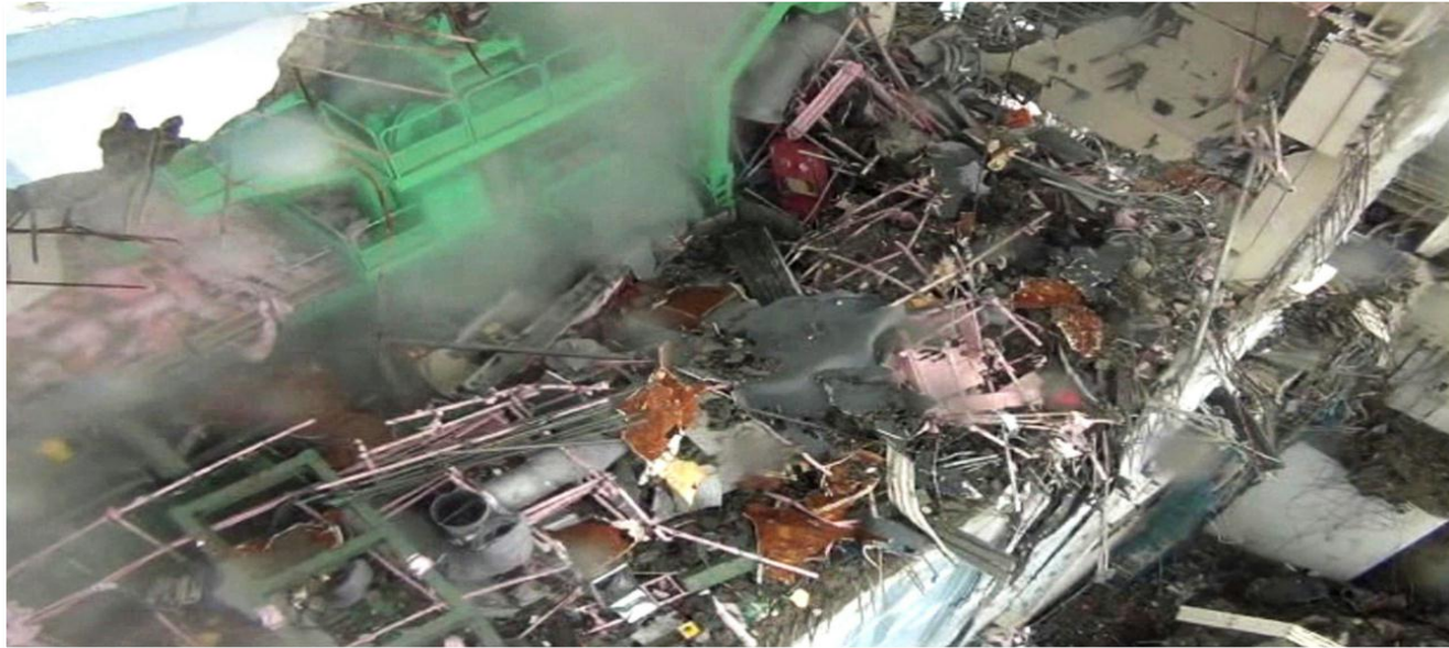
La tranche 4 de la centrale nucléaire de Fukushima Daiichi, le 24 mars 2011. (Photo : TEPCO)
