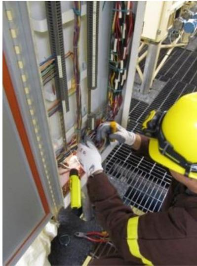
Prélèvement d'échantillons de câbles des installations de Gently-2 aux fins de vérification des hypothèses initiales. Il s'agit de l'un des endroits du site où des échantillons ont été prélevés dans le cadre de cette étude.
